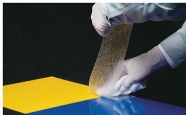
④ フィルムを剥がした面を補修箇所に合わせて、空気が入らないように貼りつけます
